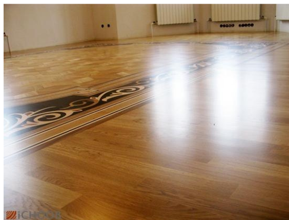
شکل ۱۲۲- نمونه اجرا شده لاک بر روی پارکت.
