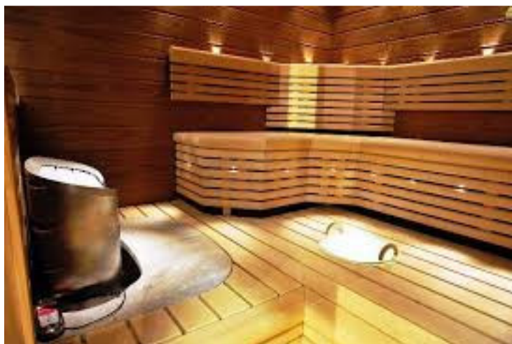
شکل ۲۳- نمونه اجرا شده از ترمووود در داخل ساختمان.
