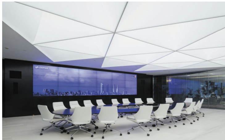
شکل ۳۱- نمونه های اجرا شده از سقف باریسول.
