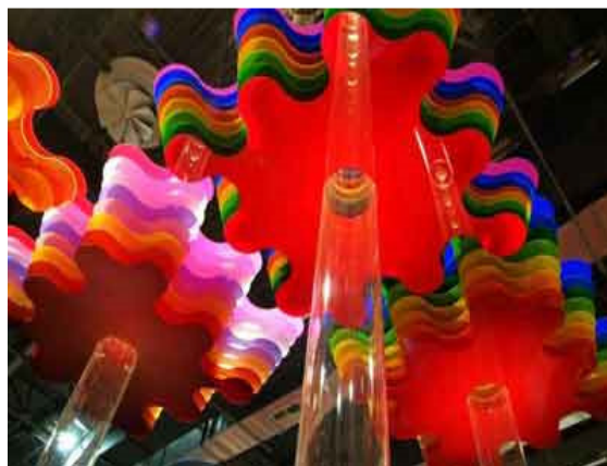
شکل ۳۰- نمونه های اجرا شده ورق های پلکسی گلاس در سقف کاذب.
