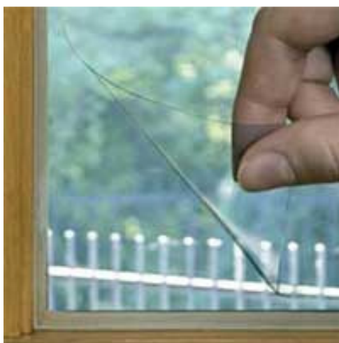
شکل ۹- نمای اجرای ویندو فیلم بر روی شیشه.
