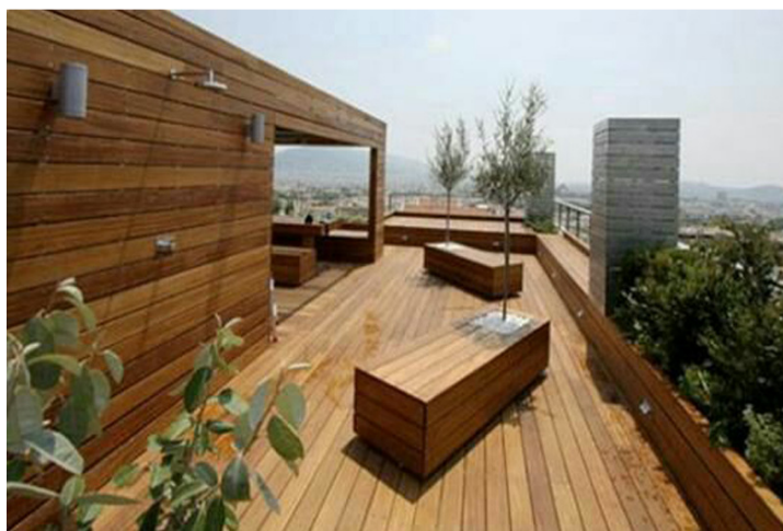
شکل ۷۴- نمونه اجرا شده از ترمووود در بالکن ساختمان.
