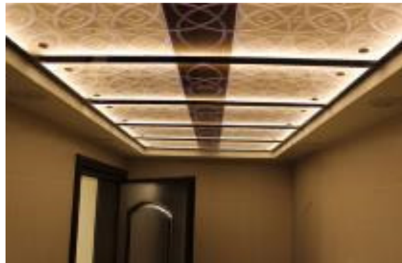
شکل ۲۶- نمونه های اجرا شده، سقف کاذب شیشه ای.
