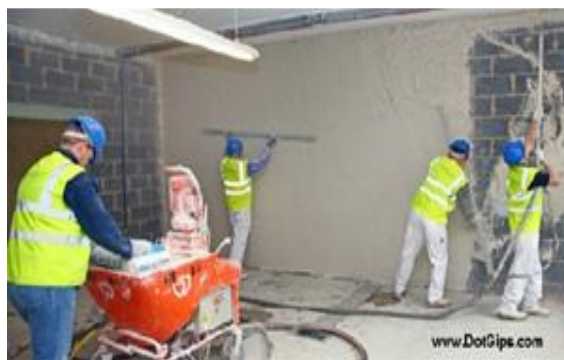
شکل ۱۲۵- نحوه اجرای گچ پاششی.
