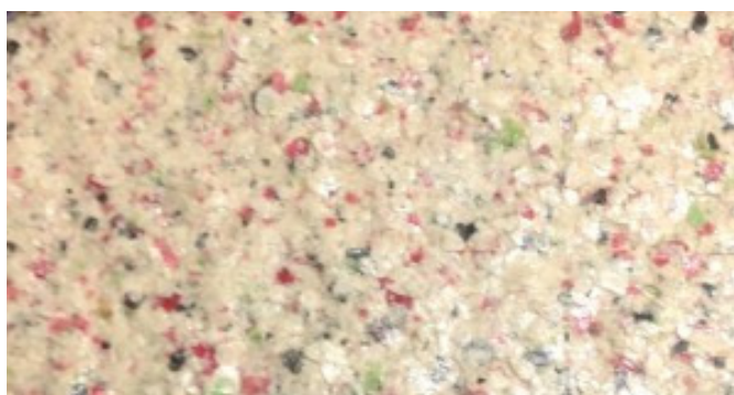
شکل ۱۲۴- نمونه اجرا شده از نمای گرانولیت پاششی .
